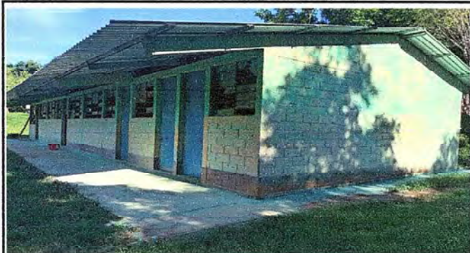
Foto 4: Instalaciones listas para pintar.
