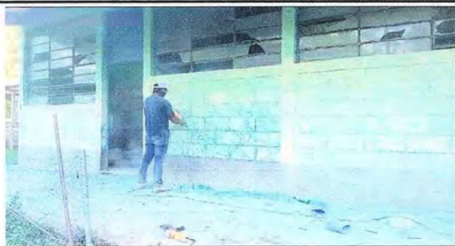
Foto 3: Para limpiar paredes se utilizo pulidora con discos especiales, ya que no era posible repintar.
