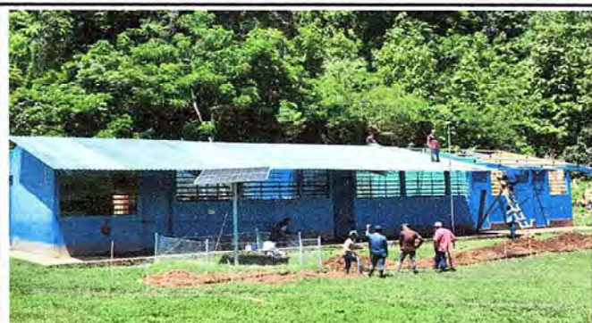
Foto 2: Instalación del nuevo entechado.
