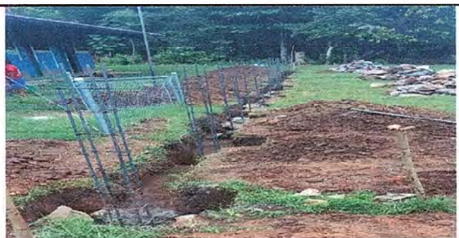
Foto 5: Cimentación del muro frontal protector del Edificio educativo.
