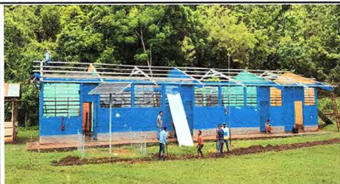
Foto 1: Montaje de nuevas bigas o tijeras que no tenia para mayor durabilidad.
