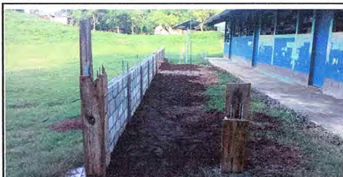
Foto 6: Altura maxima del muro como base del enmallado frontal.
